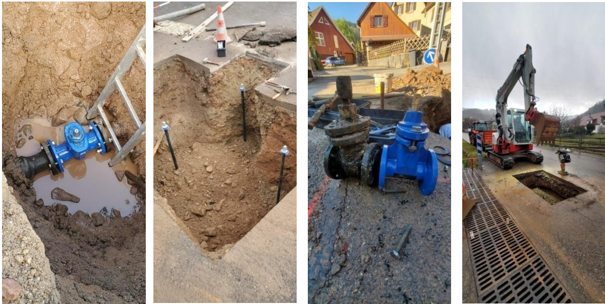
Remplacement de vannes
