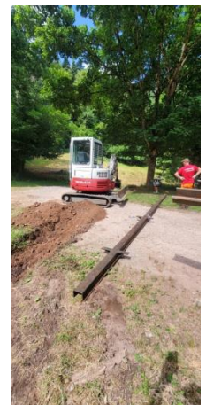
Mise en place de rigoles sur les chemins forestiers
