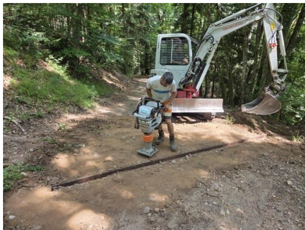
Mise en place de rigoles sur les chemins forestiers
